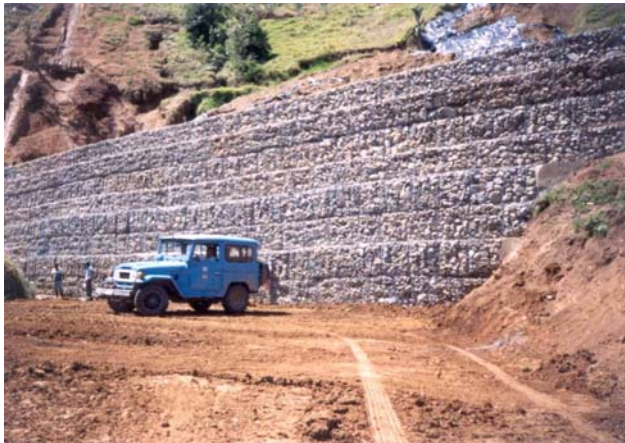
Foto 1. Muro de gaviones en "La Vuelta del Queque"
