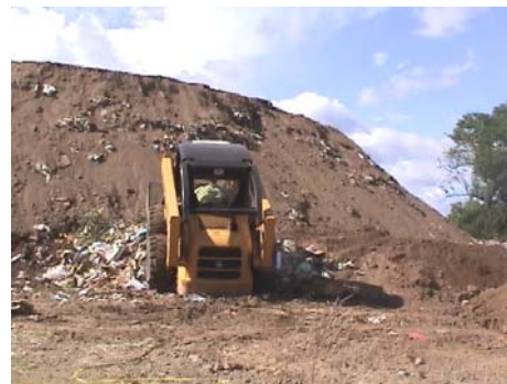
Compactación y conformación de celda
