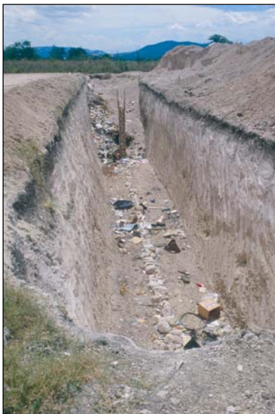
1. Izquierda: Trinchera, con drenaje y chimenea para gas
