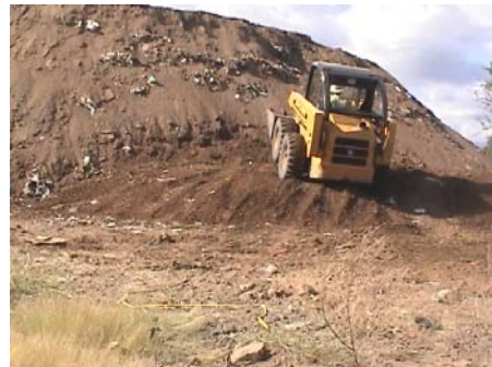
Compactación de celda
