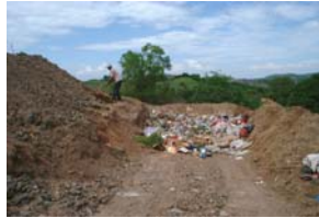
e. Extracción de material de cobertura
