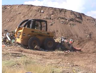
Esparcimiento de los residuos en capas, martes 21 de octubre del 2003
