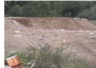
i. Terminación de primera terraza o plataforma
