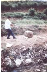
d. Compactación de los residuos
