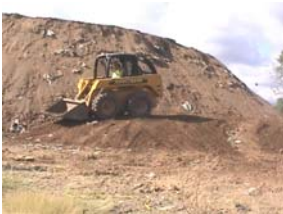
g. Compactación de material de cobertura
