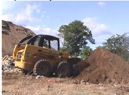
Acopio de material de cobertura
