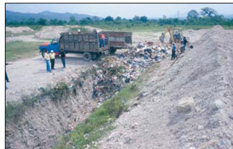
1. Izquierda: Trinchera, con drenaje y chimenea para gas
