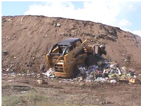
Compactación y conformación de celda
